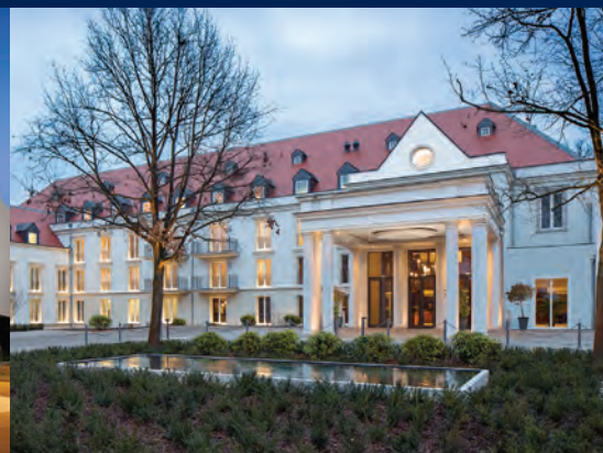
03. Februar 2016 Kempinski Hotel Frankfurt
